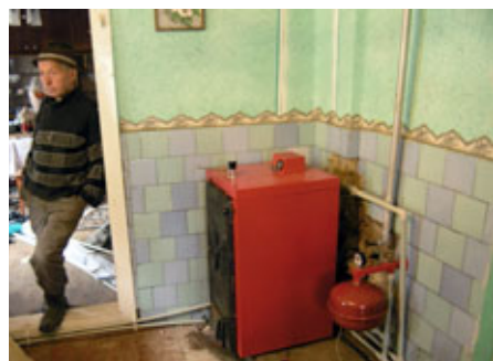
Встановлення високоефективної системи опалення в рамках експерименту з підвищення ефективності використання паливної деревини в с. Нижній Бистрий.
